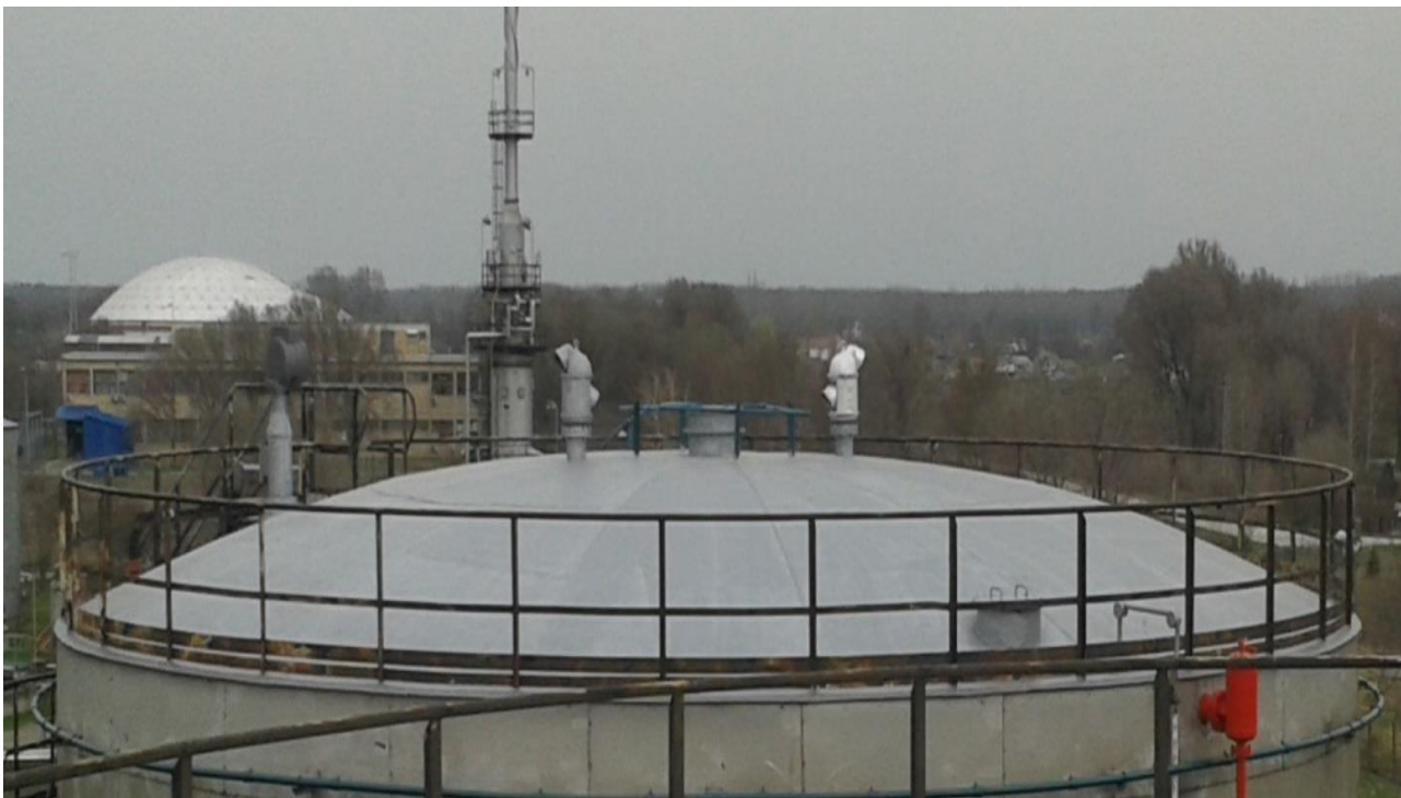
Slika 8. Rekonstrukcija rezervoara – novi krov rezervoara
