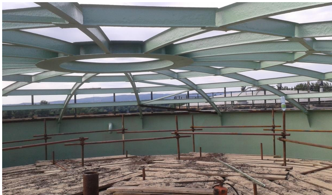
Slika 6. Rekonstrukcija rezervoara – zamena krova rezervoara
