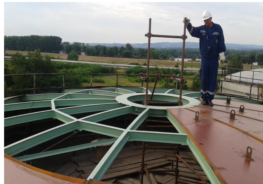
Slika 7. Rekonstrukcija rezervoara – zamena krova rezervoara – montaža novog krova (segmenti lima)
