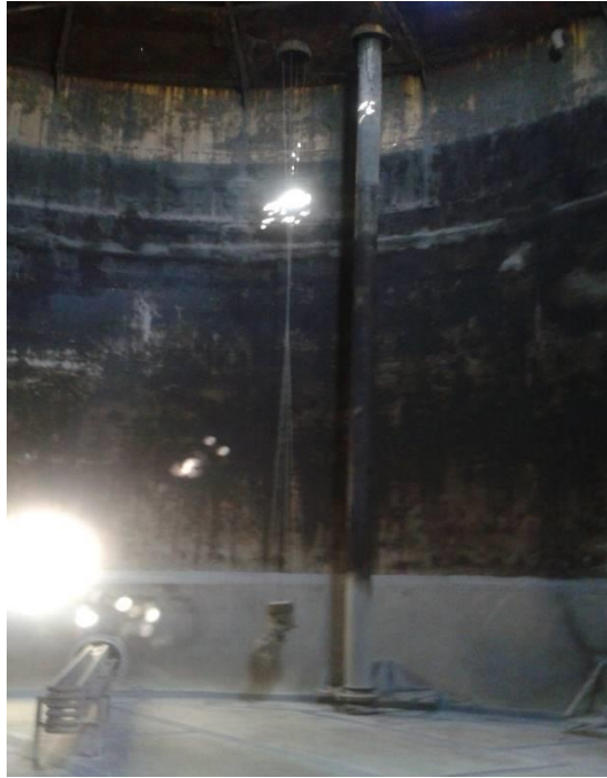
Slika 4. Remont rezervoara – ispitivanje (hidrotest) grejača
