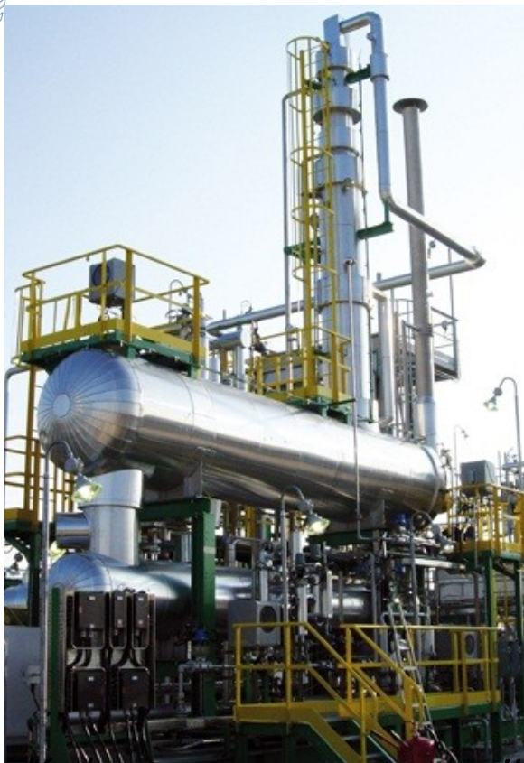
Slika 5. Kolona za regeneraciju TEG-a
